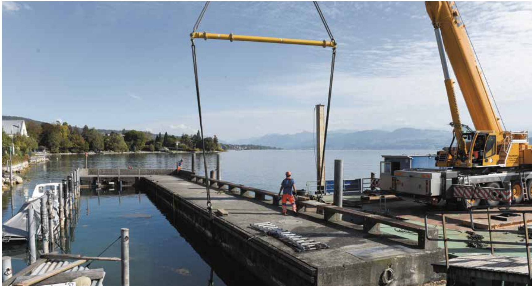
Mit einem 150-Tonnen-Pneukran wird die Mole angehoben und verschoben.
