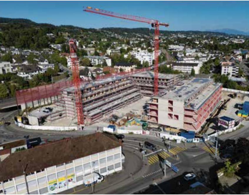
So präsentiert sich die Beugenhof-Baustelle aktuell aus der Luft. Foto: Gian Franchi, franchifly.ch
