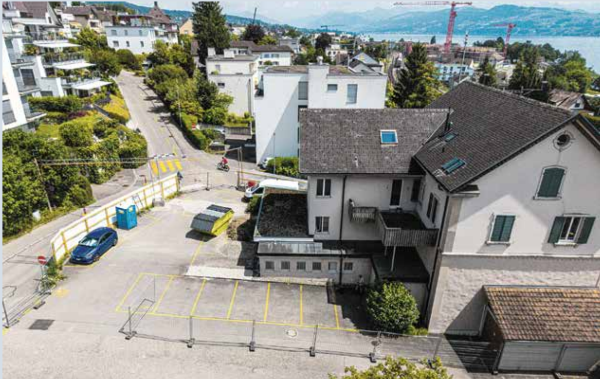
Das bestehende Gebäude der Viva Kirche (rechts im Bild) wird bald abgerissen. Foto: Beat Ungricht
