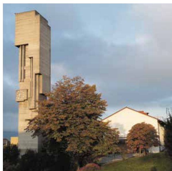
Das Gebäude wurde 1951 als moderne Saalkirche konzipiert, links der 1969 eingeweihte Glockenturm.
