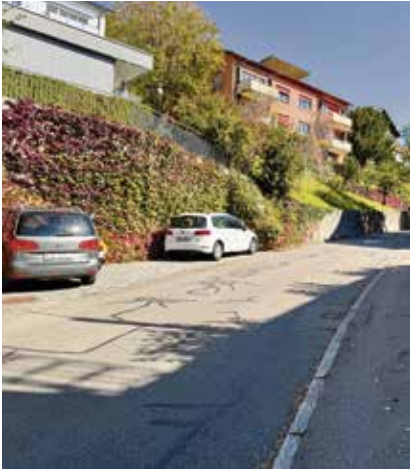
Als erstes wird der Abschnitt Bruechstrasse bis Juststrasse erneuert. Foto: MAZ
