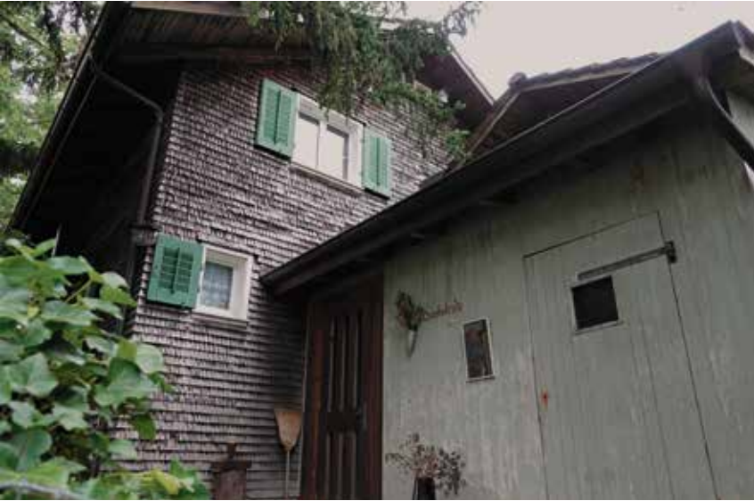
Hier entstanden viele Werke des Meilemer Künstlers Max Geiser. Heute wird das Gebäude nur noch als Ferienhaus genutzt.
