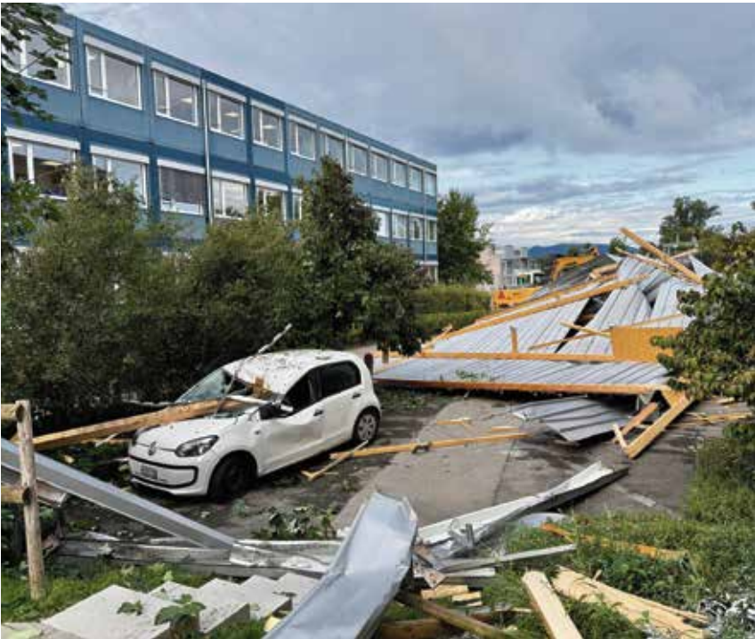
Das Auto des Kioskpächters wurde vom Dach getroffen. Foto: MAZ
