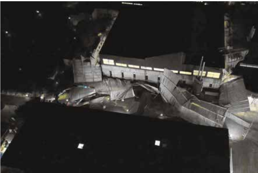
Ein Teil der Blech-Holz-Konstruktion landete auf dem benachbarten Hallenbad – die Situation gegen 22 Uhr. Foto: Drone-Air-Media.com
