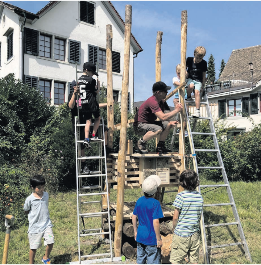
Schritt für Schritt wächst der Turm.
