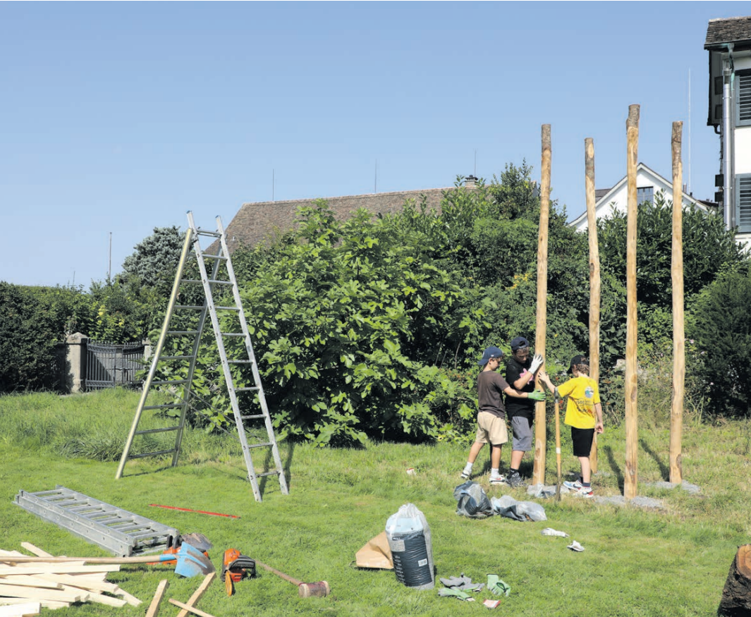
Das Pfosten müssen sicher im Boden verankert werden.
