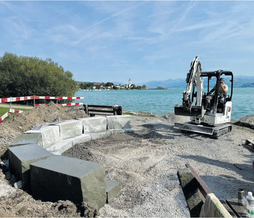
Im östlichen Teil des Feldner «Horn» entsteht direkt am Wasser eine Feuerstelle mit Aussicht. Foto: MAZ
