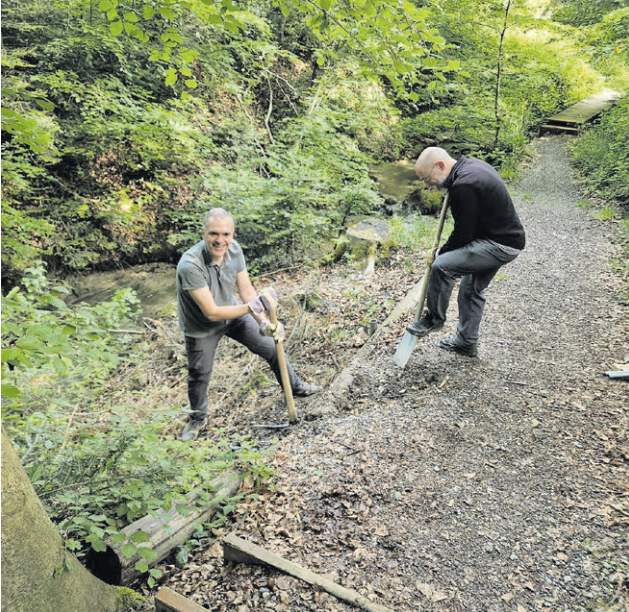
Selbst die Wegränder aus Holz wurden ersetzt oder repariert.
