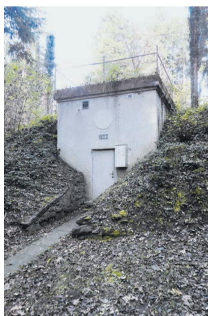
1933 am Reservoirweg 10.1 im Stil des Neuen Bauens mitten im Wald erbaut, dient das Reservoir Toggwil, obwohl öffentlich und damit von der iNFRA betrieben, mit seinem Quellwasser im Wesentlichen dem Weiler Toggwil.
