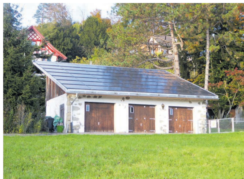
Zum ersten Reservoir Tannacher gehört ein Gebäude, das ebenerdig über keinen Zugang verfügt und nur unterirdisch mit der Anlage von 1972 verbunden ist. Wer durch eines der Fenster guckt, kann die kreisrunde Form der unterirdischen Wasserbecken erahnen.
