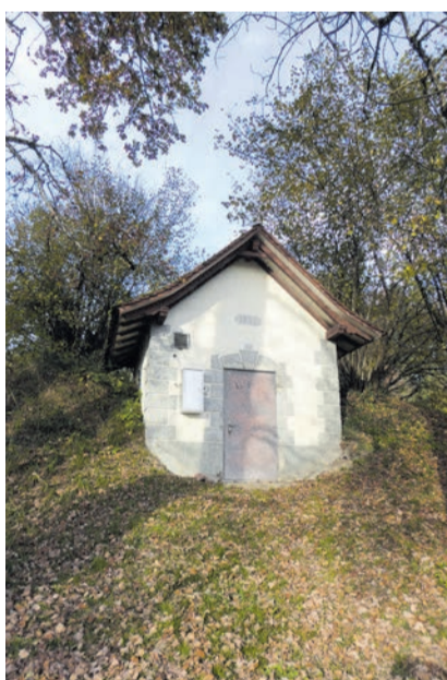
Gelegen an einem Feldweg, der westlich von der Stierengasse abzweigt, ist das Reservoir 1911 errichtet worden; es dient mit Quellwasser hauptsächlich dem Hof Bezibüel.
