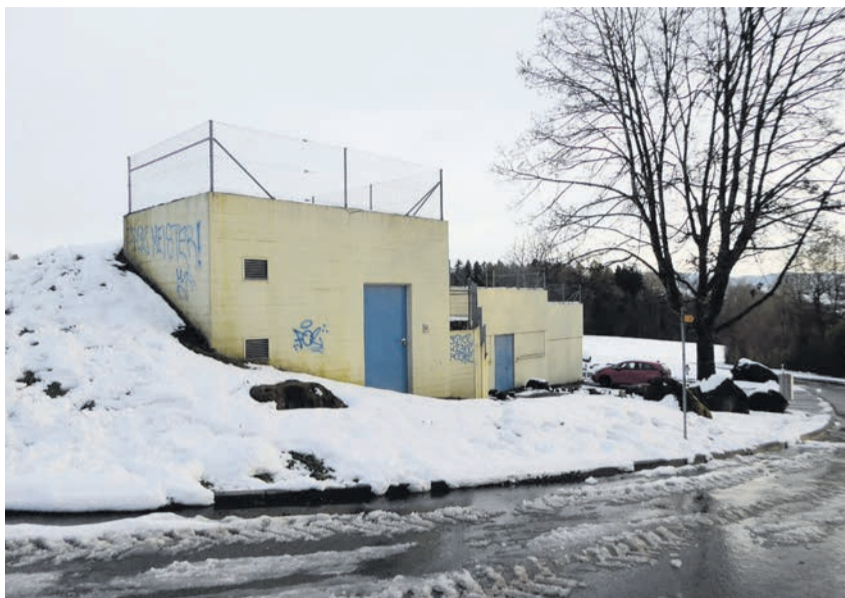
Heute ein dreiteiliger Betonklotz: Links der älteste Teil von 1897 (Schumbelstrasse 70.1), im Innern original, 1972 äusserlich überformt. Rechts folgen die modernen Anlagen: Reservoir und Pumpwerk (Schumbelstrasse 68.1).
