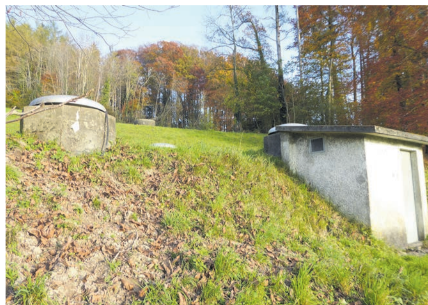
Die Wasserversorgung Burg, 1881 als Genossenschaft gegründet, versorgt noch immer die Liegenschaften des Weilers, während die «Wirtschaft zur Burg» der öffentlichen Wasserversorgung angeschlossen ist. 1927 ist das Reservoir erweitert worden.
