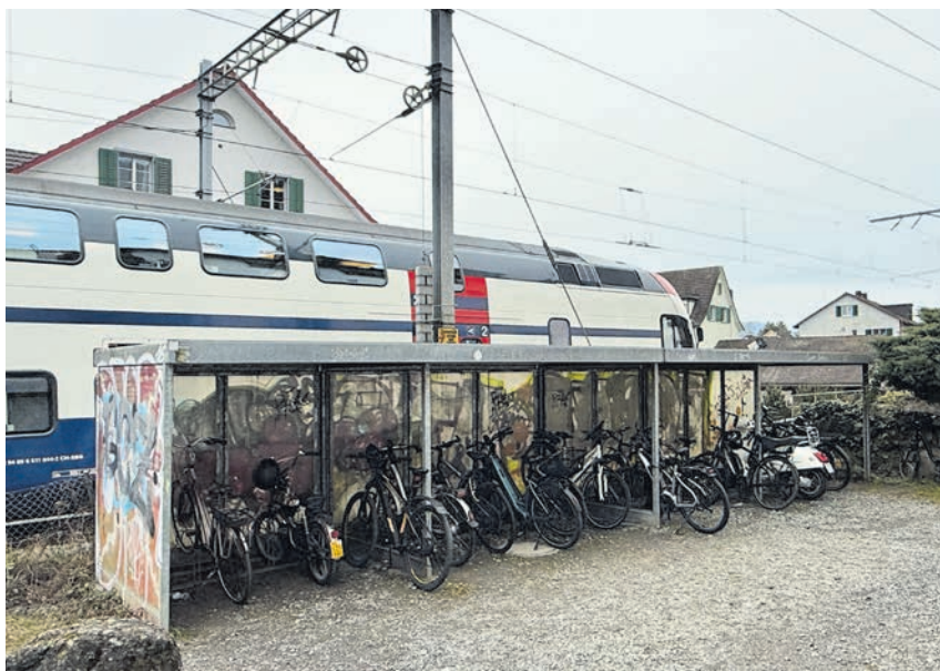
Bald neu und mit etwas mehr Platz: Der Velounterstand an der Oberen Kirchgasse.
