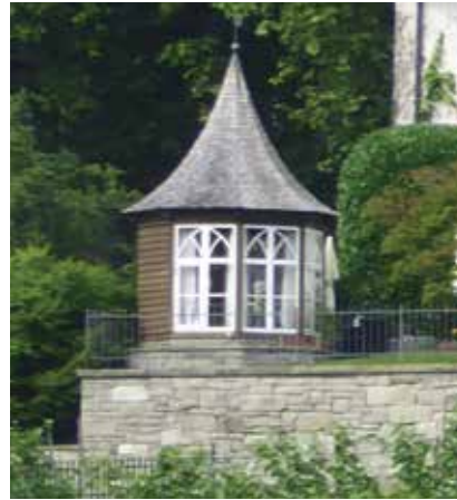
Ein kleiner Pavillon, erbaut zwar erst im 20. Jahrhundert, aber zusammengesetzt aus historischen Fenster-Elementen. Foto: pkm
