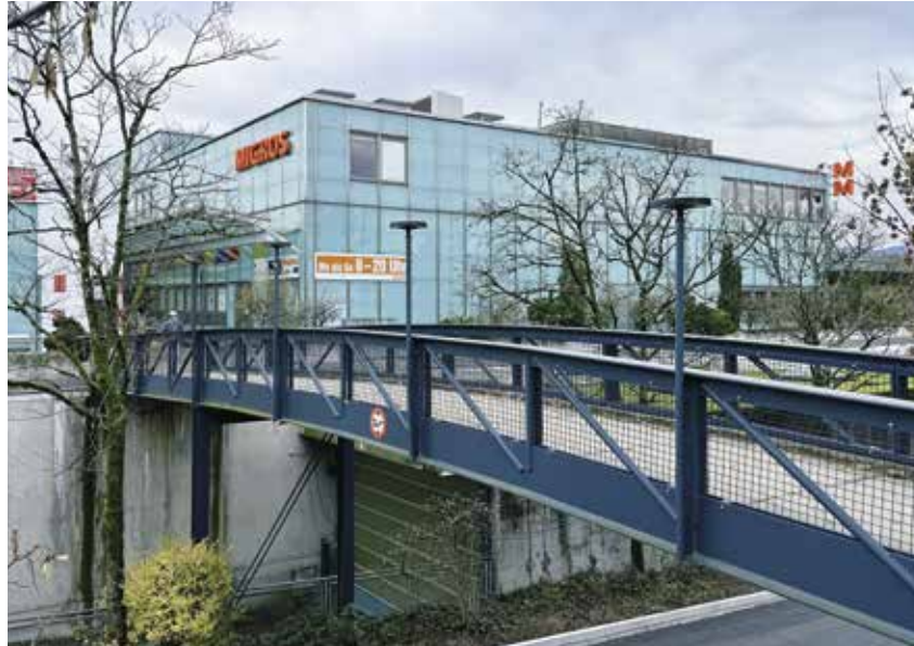
Zuerst wird die Gebäudehülle der Migros saniert, erst nachher folgen Supermarkt und Restaurant. Foto: MAZ
