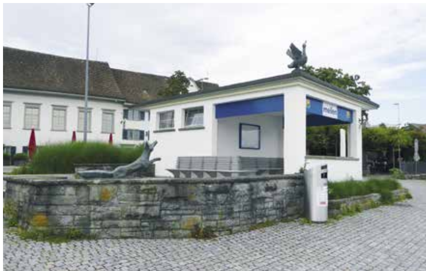
Das Warte- und WC-Häuschen im Stil des Neuen Bauens samt skulpturalem Schmuck von Hans Jakob Meyer. Foto: pkm
