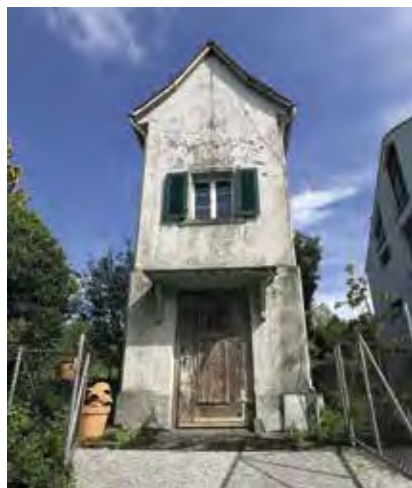
Trafohäuschen Schwabach. Foto: MAZ
