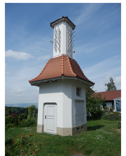
Ehemaliges Trafohäuschen der ersten Generation in Ottikon (Gossau ZH).
