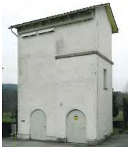
Das Trafohäuschen Hohenegg. Foto: J. Welti
