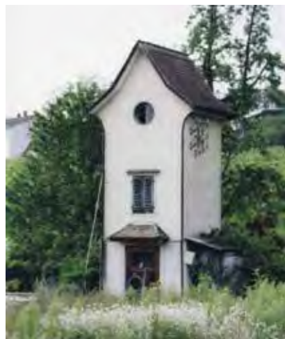
Abbild des 2015 abgebrochenen Trafotürmchens Rorguet. Foto: OMM
