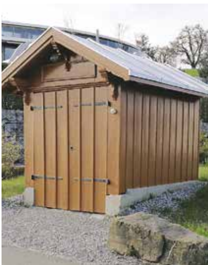
Renoviertes Schlauchwagenhäuschen Durststrasse, Details noch nicht geklärt.
