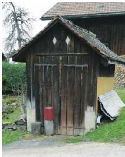
Schlauchwagenhäuschen im Weiler Hinterer Pfannenstiel, Details noch nicht geklärt.
