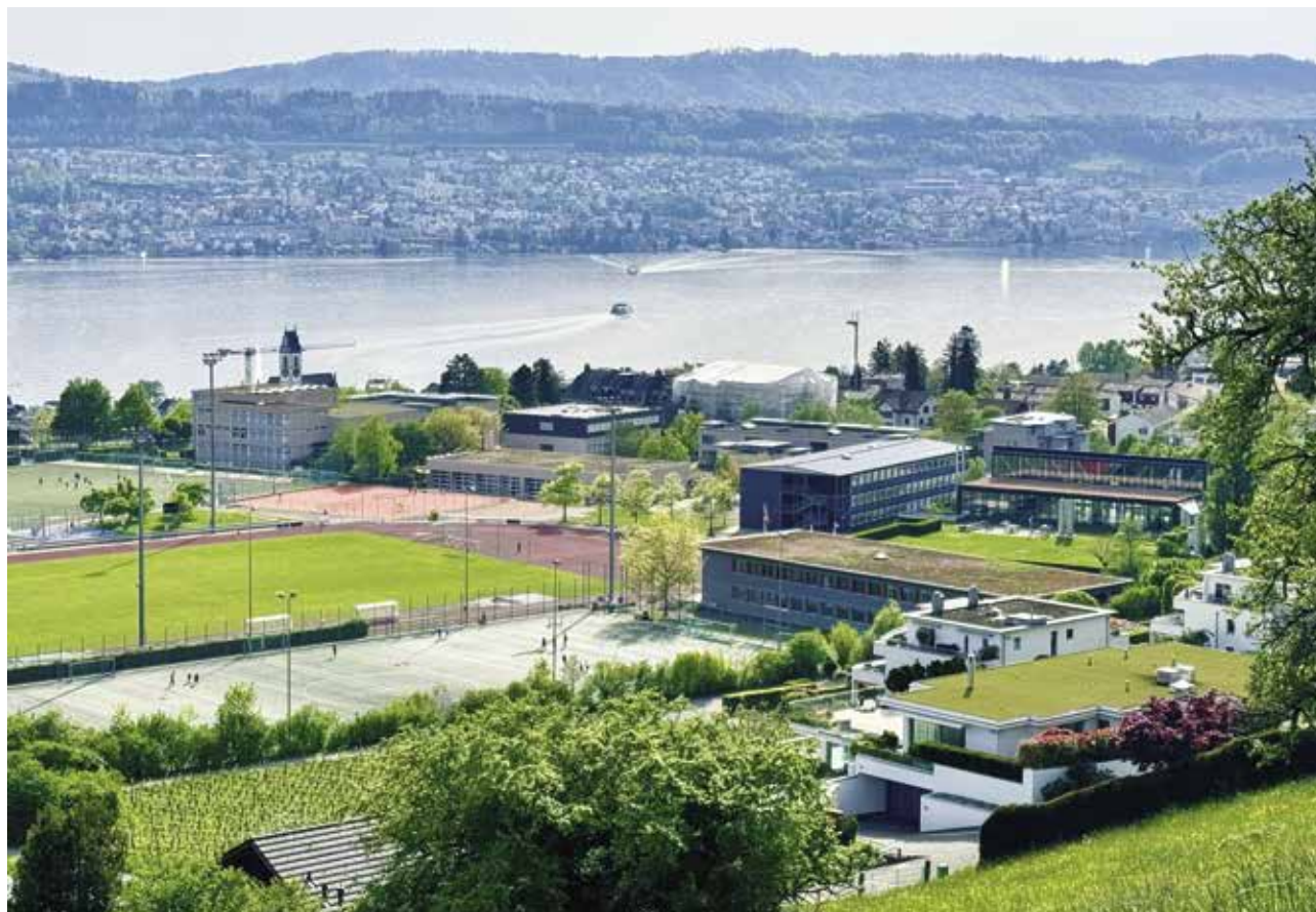
Die Erneuerung und Erweiterung von Gebäuden auf der Allmend innerhalb der nächsten zehn Jahre wird um die 70 Mio. Franken kosten.
