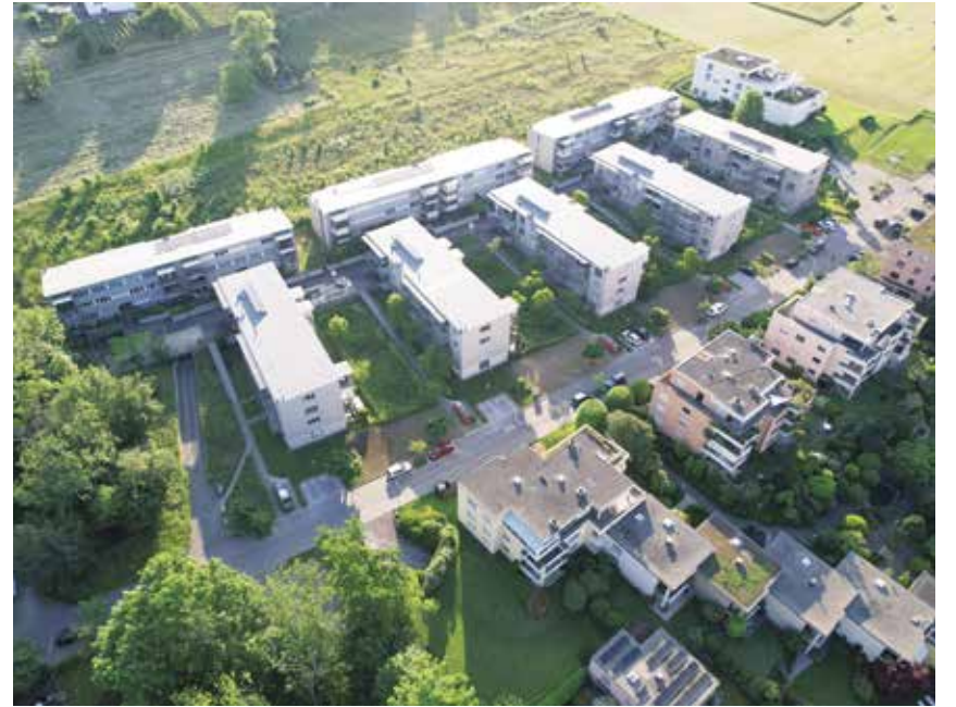
An der Ländischstrasse in Feldmeilen vermietet die Gewomag 87 Wohnungen.
