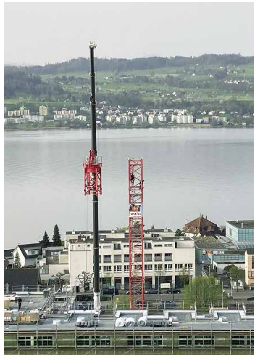
Anfang dieser Woche wurde auf der Baustelle «Stelzen» in Dorfmeilen der Kran demontiert.
