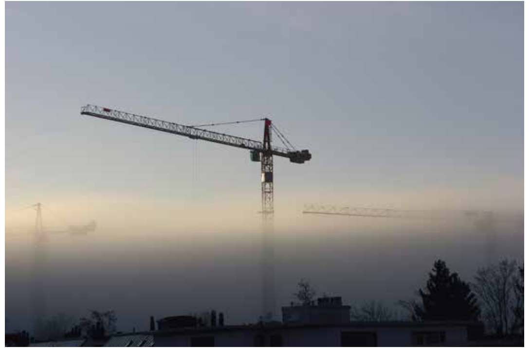
Die Baustelle für die Siedlung Burkwil in Obermeilen erwacht aus dem Morgennebel – der Kranführer ist bereits über den Wolken.
