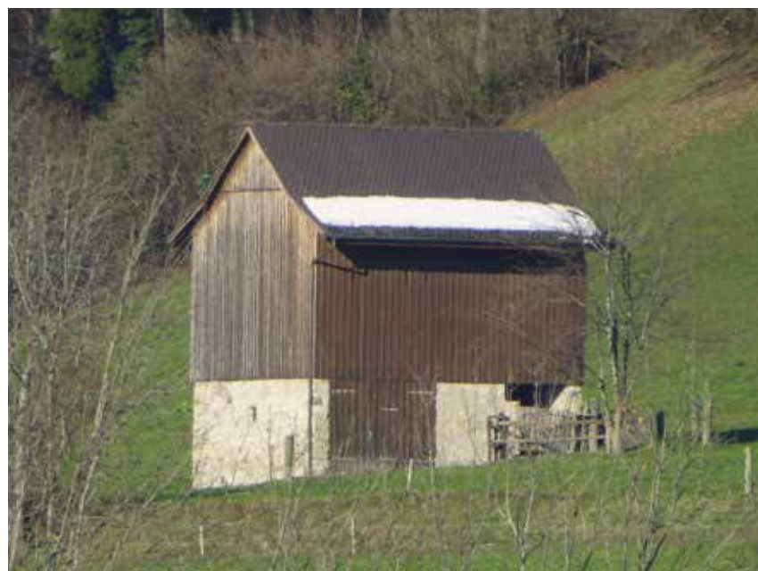
Bei den Gebäuden handelt sich ausnahmslos um «verkleidete» Fachwerkbauten.
