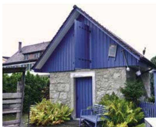
Unverputztes, nicht weiter geschmücktes Bruchsteinmauerwerk mit hölzerner Giebelzone (1851), daran heute Waschbrett, Wäschestampfer und kleine Gelte aufgehängt; als Gebäude besonders gepflegt; Im Dörfli.
