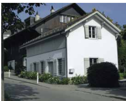
Im 20./21. Jahrhundert lange Jahre Kunstgalerie, Obergeschoss traufseitig aus Holz, mit von-Salis-Wappen, heute bewohnt (1864); Schwabachstrasse.
