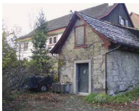
Unverputztes Bruchsteinmauerwerk mit Splittern von rotem Ackerstein, eine sehr traditionelle Bauweise (wohl 18. Jahrhundert, nachgewiesen seit 1813); Alte Landstrasse Dollikon.
