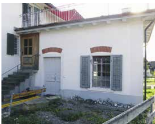
Quer angebaut mit Zinne, über den Fenstern rote Entlastungsbögen aus Backstein (1906); Auf der Halten.
