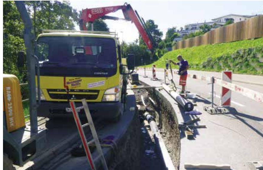
Mike Grab beim Verlegen der Goldingerleitung in Hombrechtikon..
