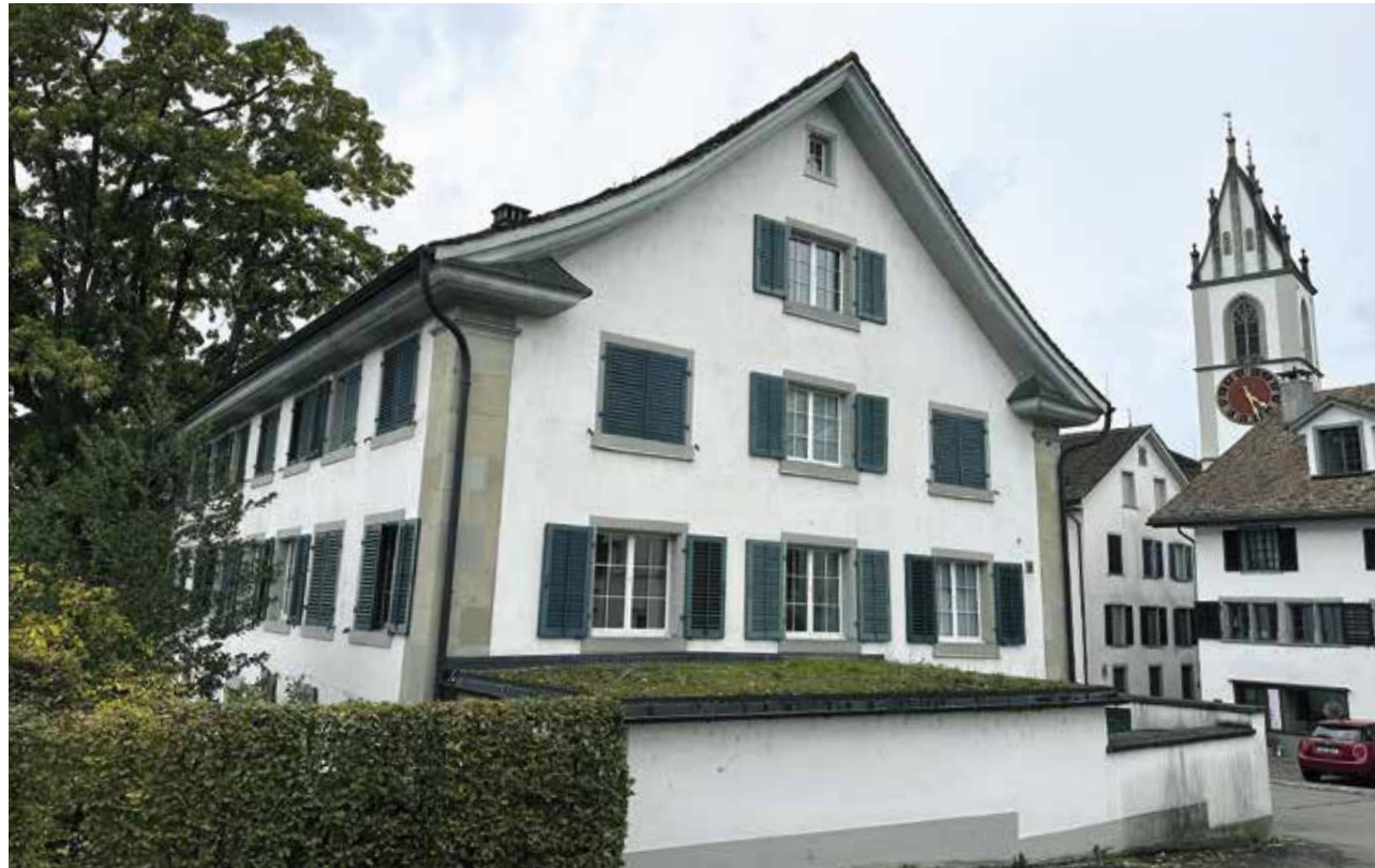
Das Pfarrhaus am See ist nun mit einer modernen Brandmeldeanlage ausgestattet.
