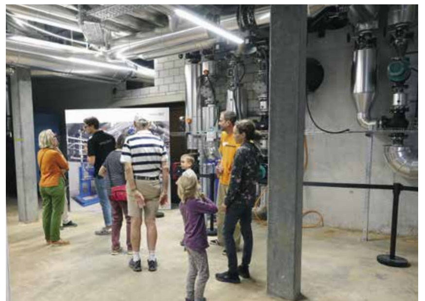
Mitarbeiter der Energie 360° erklären den Besuchern die Anlage.
