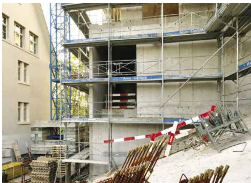
Die Markthalle steht am Dorfplatz. Links die wiederhergestellte Nordfassade des ehemaligen Sektorschulhauses, im Vordergrund die Schräge für den Anschluss der Dorfplatztreppe.
