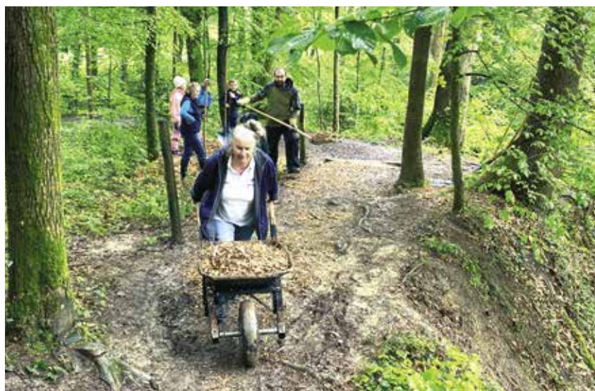
Auch die Arbeiten zur Instandstellung erwiesen sich als Krafttraining. Foto: zvg
