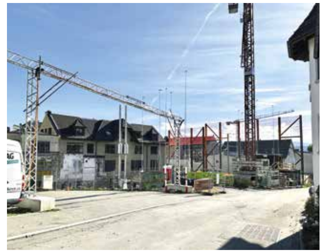
Der Bau der Energiezentrale an der oberen Kirchgasse hat im Juni begonnen. Foto: MAZ
