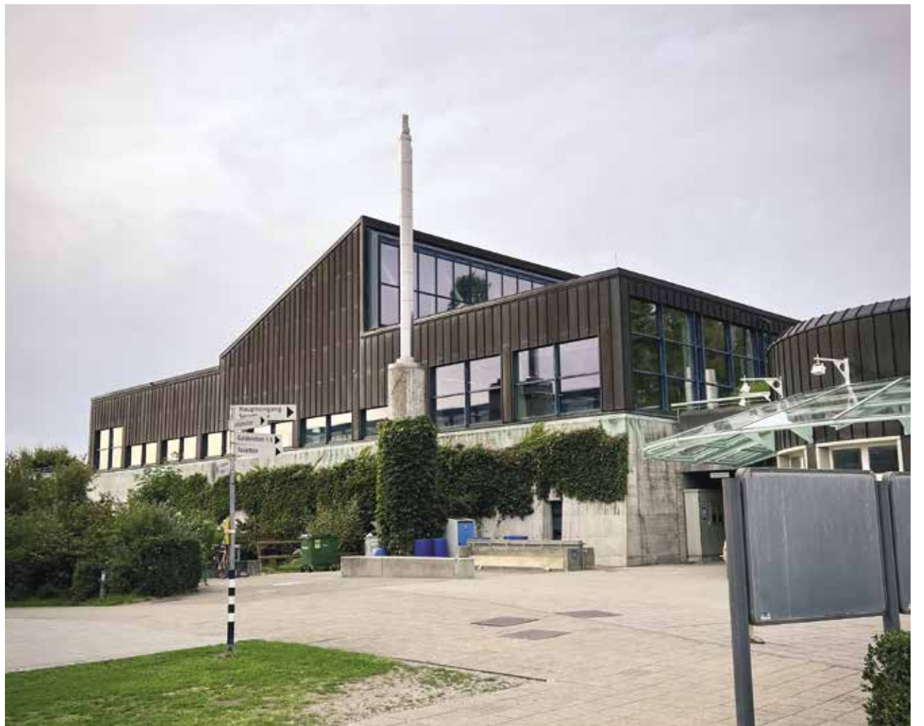
Die Schliessung des Hallenbads wäre erst ein Thema, wenn es zu einer Kontingentierung der Energie kommt.
