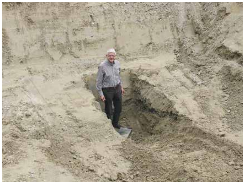
Gemeindepräsident Christoph Hiller samt Zeitkapsel am tiefsten Punkt der Baugrube.
