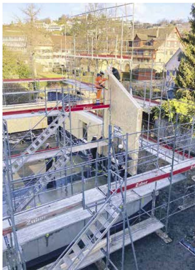
Anfang Woche wurden die neuen Aussenwände aufgebaut.
