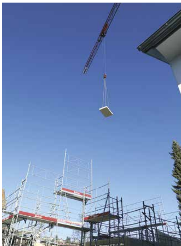
Anlieferung der Holzelemente auf dem Luftweg.
