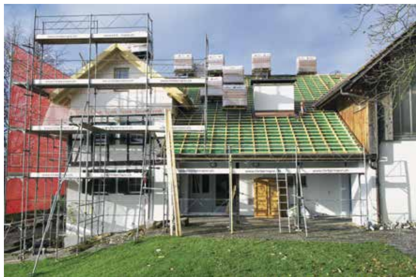
Das Pfadiheim wurde saniert – auch mit Hilfe der Pfadis selber, die Fronarbeit leisteten.
