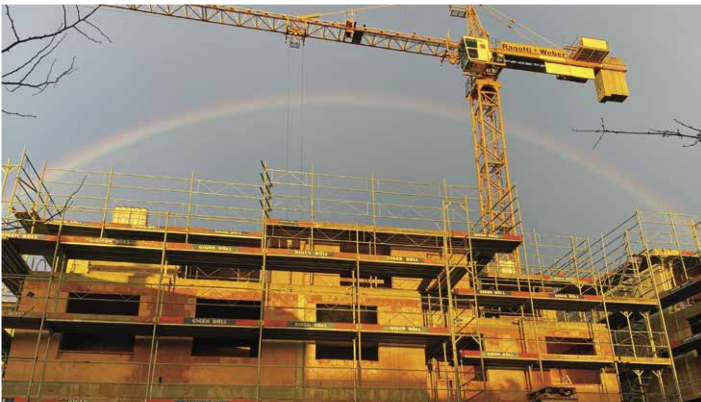
Ein Regenbogen ist auch über einer Baustelle schön: «Vielleicht bringt er den zukünftigen Bewohnern des Hauses ja Glück», schreibt Monica Spinaz zu diesem Schnappschuss.
