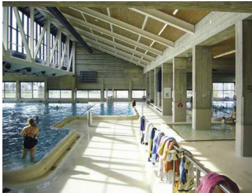
Das Hallenbad Meilen wurde vor einigen Jahren insbesondere energietechnisch auf den neusten Stand gebracht. Foto: zvg
