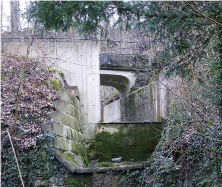
Der Hochwasserüberlauf.
