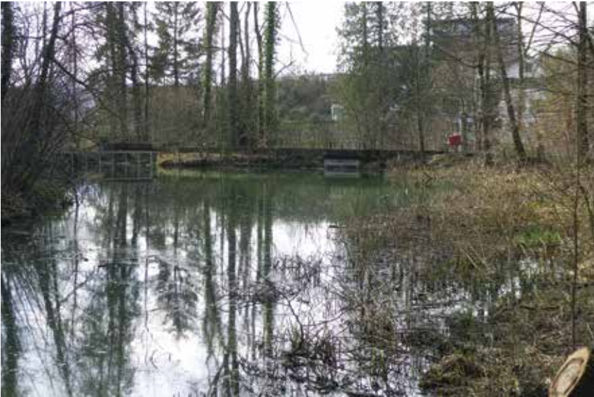
Der Weiher in Blickrichtung Damm mit Zulauf zum Hochwasserüberlauf (links), «Normalüberlauf» und Grundablass (rechts).
