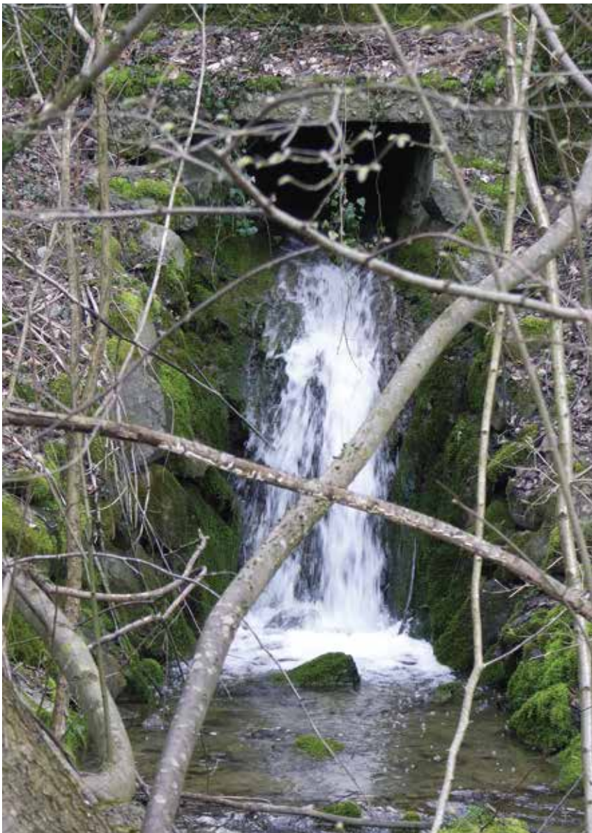
Der Bachauslauf aus dem Schacht mit «Normalüberlauf» und Grundablass. Der Bachauslauf fliesst aus dem Schacht auf Höhe des Grundablasses.
