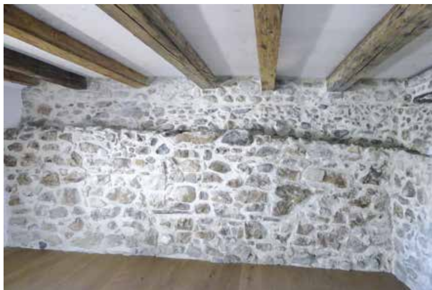
Das Mauerwerk besteht teilweise aus Bruchsteinen.
