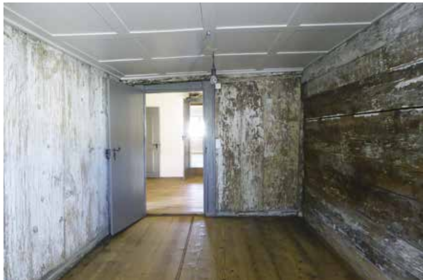
Wände aus stehenden und liegenden Bohlen (Schnittholz).
