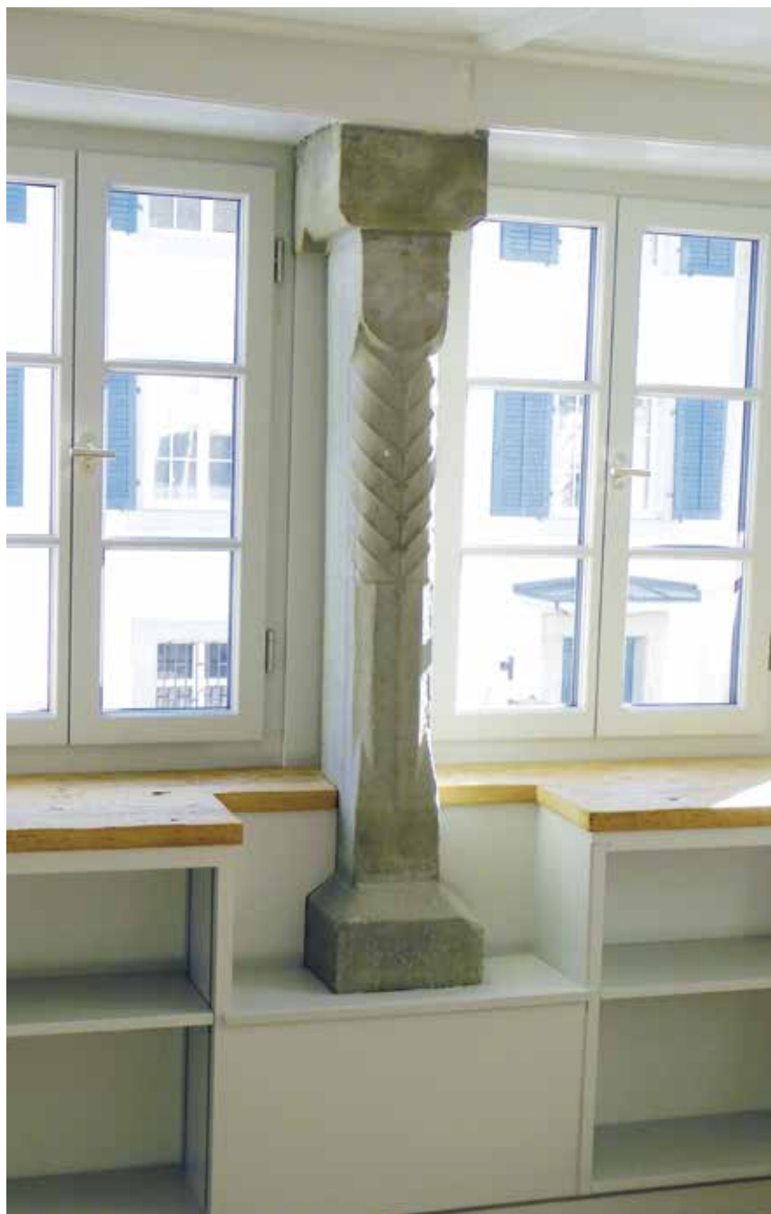
Spätgotische Fenstersäule in der Stube des Gebäudes.
