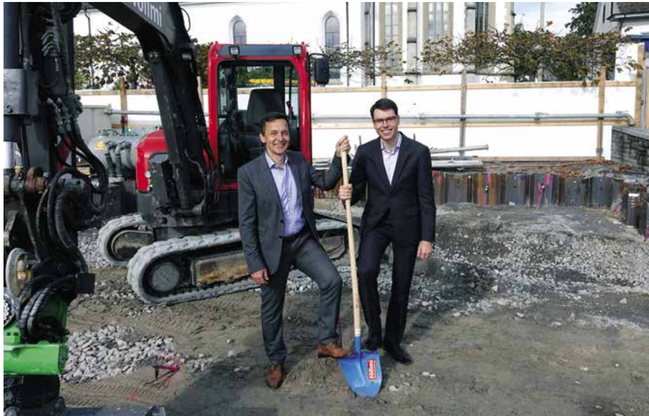
Romeo Deplazes von Energie 360° (links) und Peter Brändle, CEO der Midor AG, eröffnen die Arbeiten in der Seeanlage.
