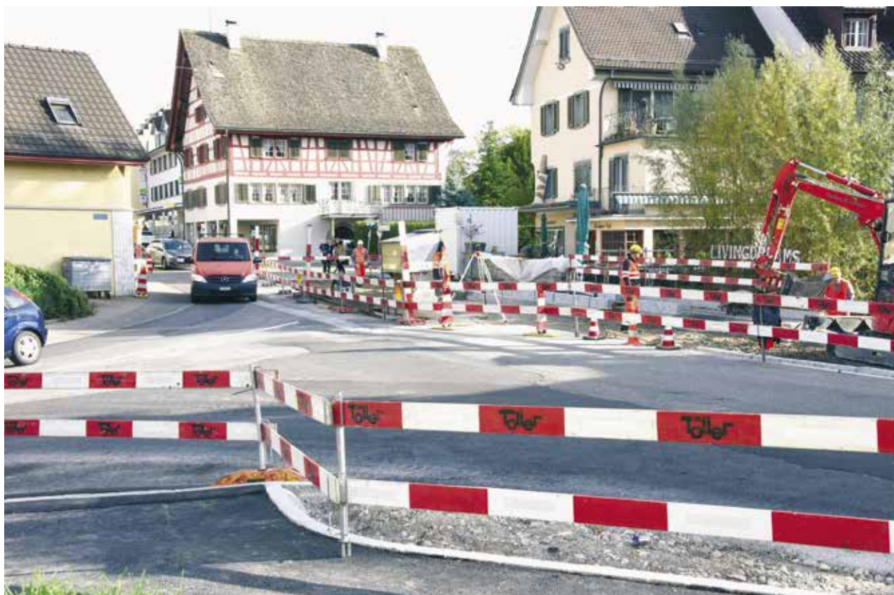
Der zürichseitige Eingang zu Dorfmeilen wird zurzeit saniert.
