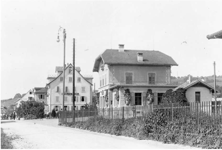
Das Meilemer Stationsgebäude besteht noch heute. Es wurde als «Standard-Bahnhof Typus IIIa» von Architekt Gustav Wülflke entworfen und 1893/94 erstellt.
