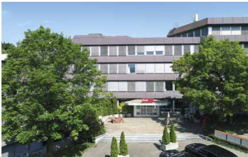
Der Eingangsbereich des Hoval-Gebäudes in Feldmeilen. Foto: Daniel Sabater
