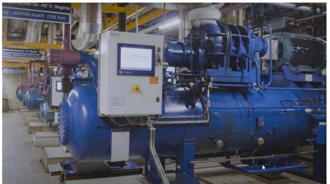
Über drei grosse Kompressoren macht die Delica AG die Energie als Kälte zur Klimatisierung der Produktion, aber auch der Produktionsprozesse nutzbar.
