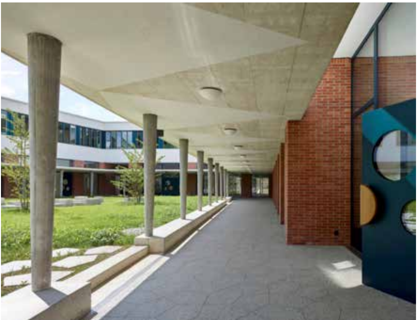
Schule Feldmeilen, Neubau Primarschulhaus. Foto: neon deiss Architekten, Zürich
