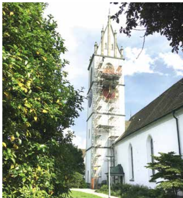
Das Baugerüst bleibt voraussichtlich bis Mitte September stehen.
