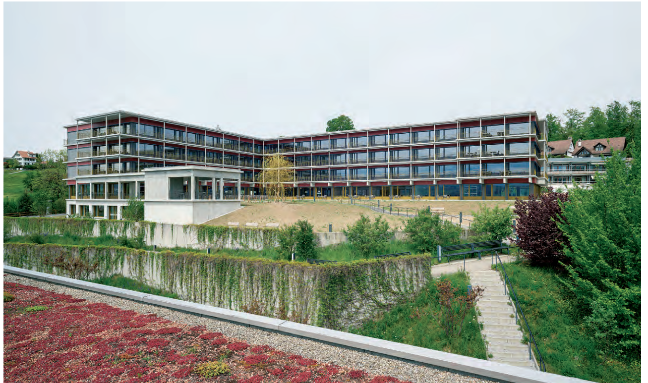
Von den ersten Gedanken an einen Neubau bis zum fertigen Gebäude verging eine Dekade: Das neue Weiherhaus des Alterszentrums Platten mit 84 Pflegeplätzen.
