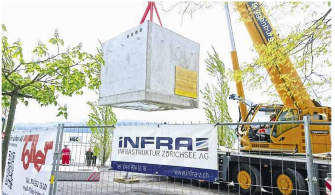
Bauarbeiten in vollem Gange: Der Schacht für die Seewasser-Pumpen wird mit Hilfe eines Krans in die ausgehobene Grube platziert.
