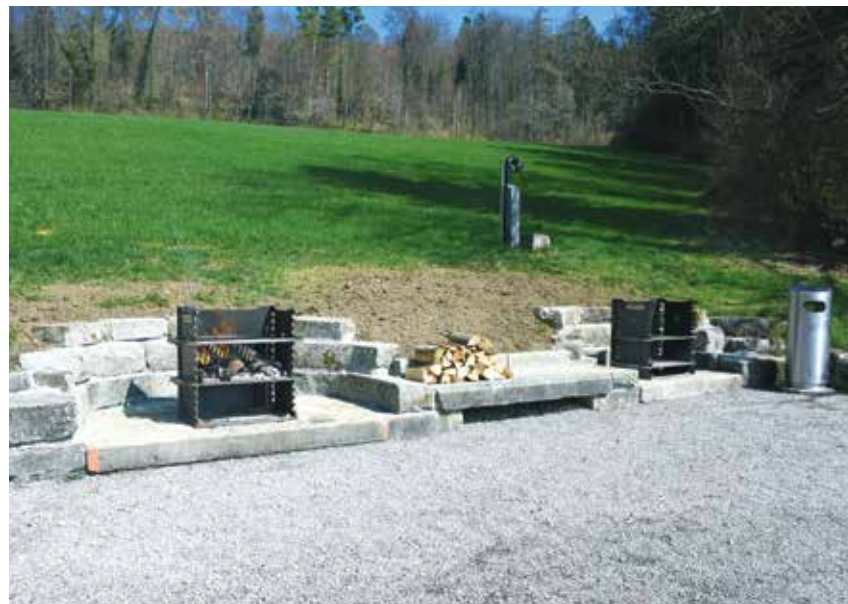
Die beiden Panzergrills stehen fest montiert auf steinernen Fundamenten.
