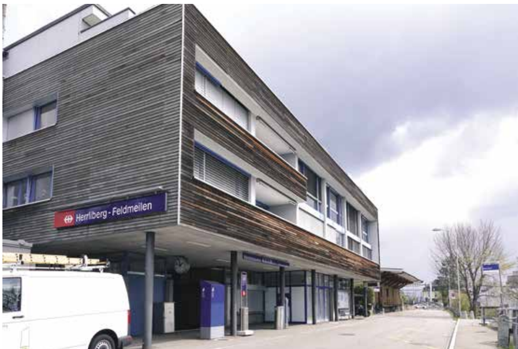
Das Bahnhofsgebäude soll durch einen Neubau ersetzt werden.
