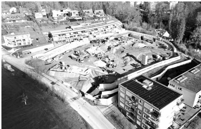
Auf der Platten entsteht bis im Frühjahr 2021 das neue Zuhause für Pflegebedürftige.
